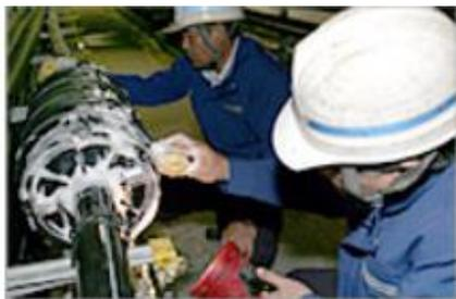
通信ケーブル内部には圧縮空気が送り込まれている。監視システムから導き出した箇所に石鹸水を塗布することで、目に見えない穴や亀裂を見つけ出す
